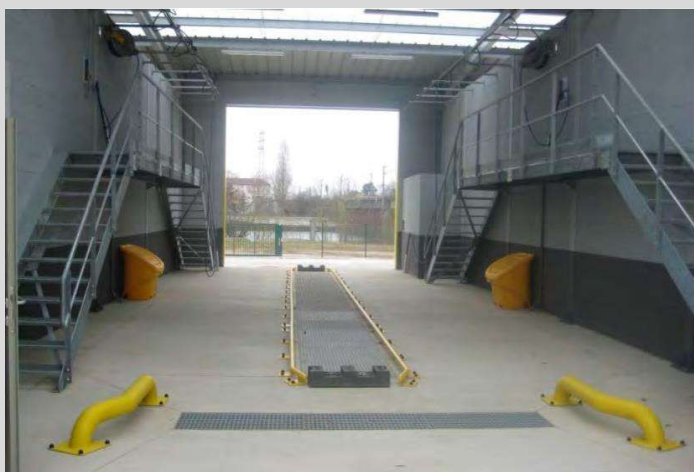
Aménagement type d'une travée de lavage conforme aux prescriptions du programme SCORPION
