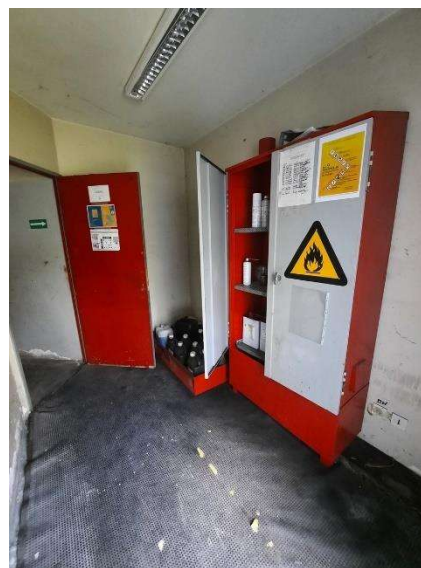
Local stockage produits dangereux, aucune ventilation
